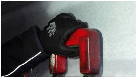
Nachträgliche, vor Ort durchgeführte MT-Prüfung, um Risse im Stahlbauteil zu identifizieren. (Quelle: Finke)
