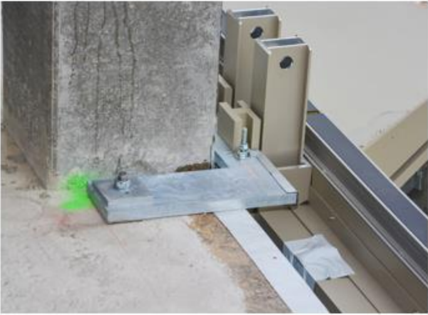
Detailaufnahmen der Fassadenmontage
