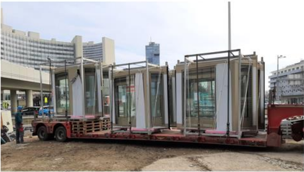
Anlieferung – 200 Transporte mit Tieflader
